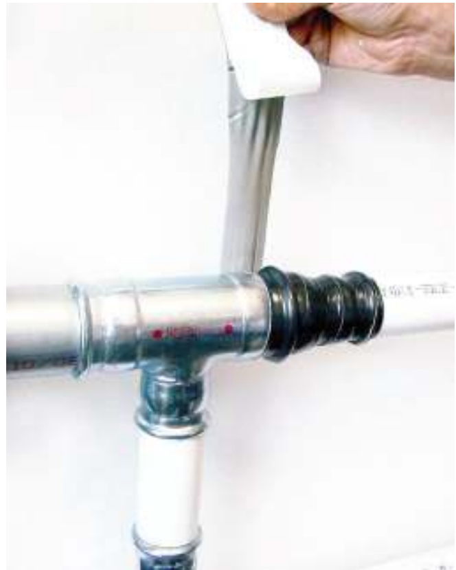
Рис. 38. Защита соединений с помощью бутаноловой клейкой ленты.
